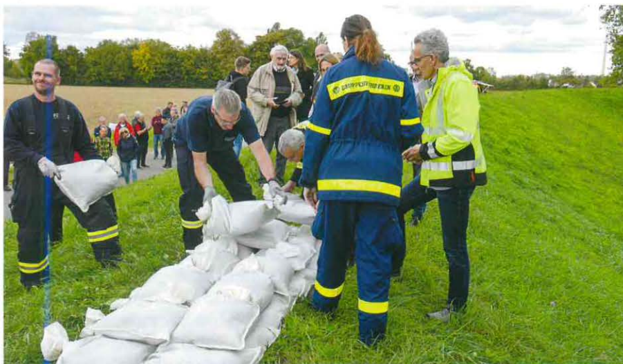
Station „Deicherhöhung“: Einweisung der Hilfskräfte durch Deichmeisterei und Fachberatung THW
